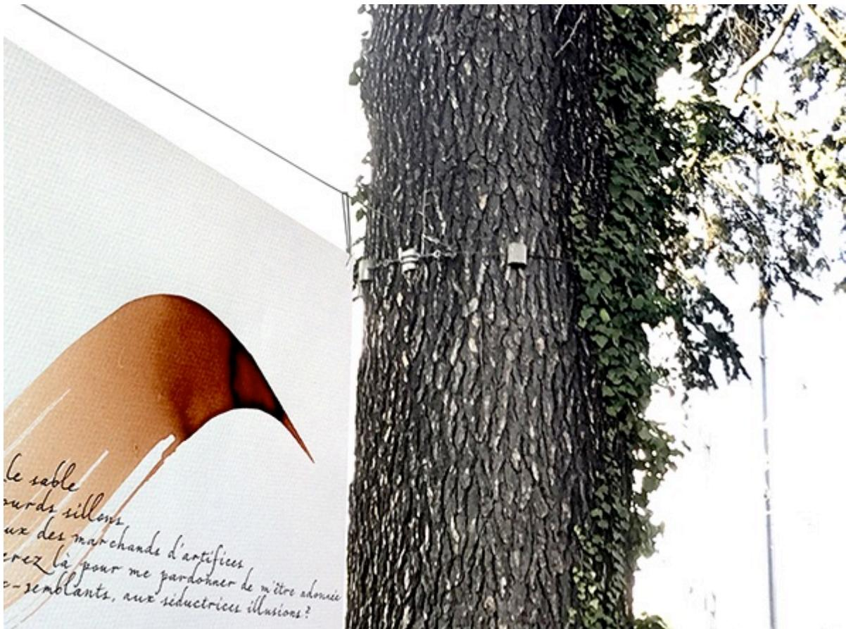
Système d'accrochage des kakémons : 2 câbles en haut et en bas, tendus sur 2 supports (arbres, poteaux, etc.) Kakémons avec œilletons et petit câbles d'accrochage aux gros câbles.
