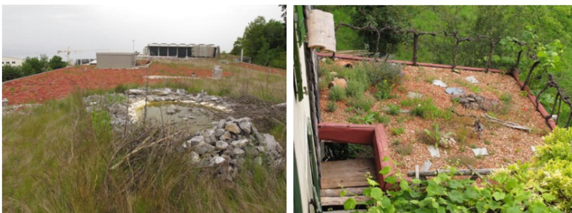
Figure 6 : exemples de toitures végétalisées "biodiversité" avec des petites structures (© Aino Adriaens)
